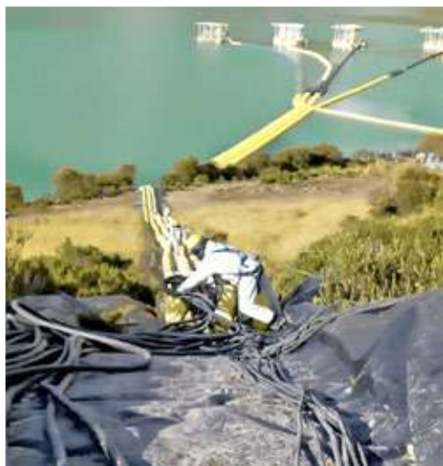
Reordenamiento de cables eléctricos hacia las barcazas
